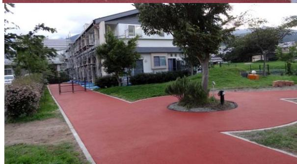
平成27年度日本郵便の年賀寄附の助成を受けて「聴導犬・介助犬用屋外歩行訓練場(トレーニング・ロード)舗装を車椅子対応に改修する事業」が2015年7月完成いたしました。車椅子での歩行が容易であり、候補犬にとってもクッション性による足への負担と、反射熱の軽減がなされる。介助犬での歩行訓練に影響されにくい耐候性、透水性も高い舗装資材 GPM 導入が実現できました。ウレタンパーソフト GPM は、公園などの遊具周り、多目的広場ジョギングコースなどに使用されており、これを幅約3M×長さ約72M の舗装改修工事を行い介助犬希望者のみならず、聴導犬および介助犬の候補犬にとっても大切な歩行訓練や体力作りの場として全天候型で使用できます。質の高い補助犬の供給を可能とする屋外訓練場の改修工事にご支援を賜りましたこと心より感謝申し上げます。
